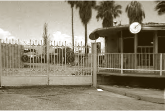
Puerta de entrada y caseta de vigilancia de la vinícola Viejo Verjel, que dejó de producir vinos en 1995.
